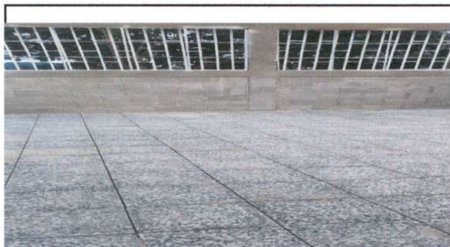
Foto 5: Sustrucción de piso torta de concreto por granito (aula 1)
