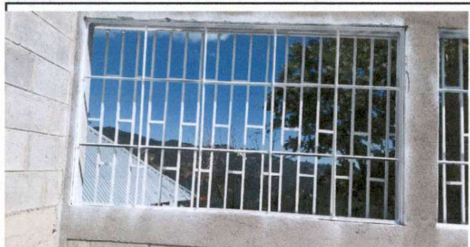
Foto 1: Sustrucción de ventanas de madera por metal (Modulo 1)
