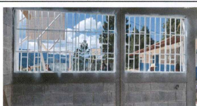
Foto 2: Sustrucción de Balcones de madera por metal (módulo 1)
