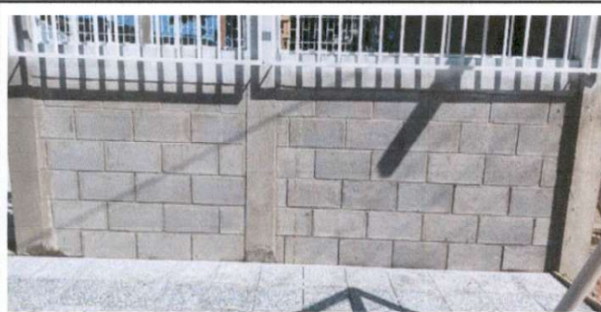
Foto 3: Sustrucción de piso de torta de concreto por granito (módulo 1 patio)
